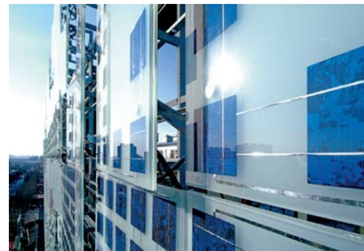
光电太阳能板压到幕墙玻璃中
